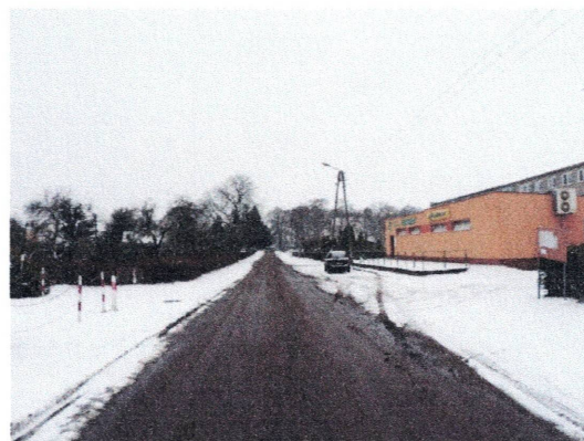
Zdjęcie nr 16 – Droga w centrum miejscowości
