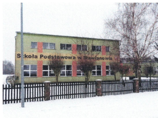
Zdjęcie nr 20 – Budynek Szkoły Podstawowej
