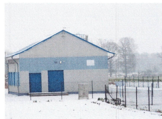
Zdjęcie nr 21 – Stacja uzdatniania wody
